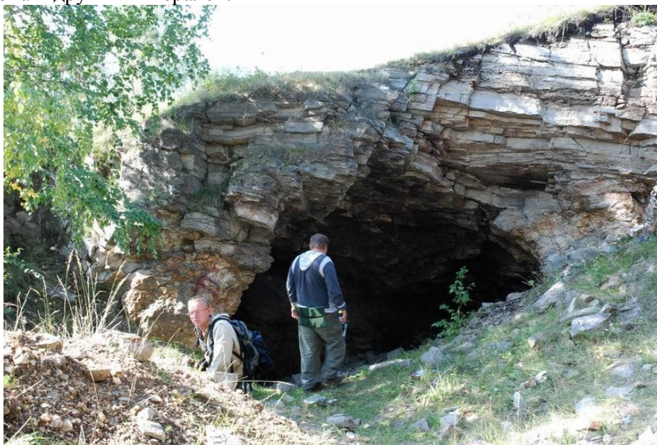
Рис. 6. Горные выработки на жиле № 5 щелочного пегматита, залегающей на склоне горы Каравай.
